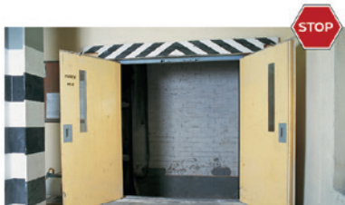
Huecos de ascensor o montacargas
